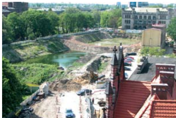
Fundamenty NFM, zdj. Urząd Miasta we Wrocławiu
